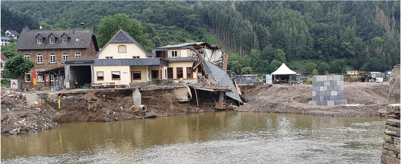
Beispiel: Abbruchkante in Dernau ( Foto vom 26.08.2021 )
